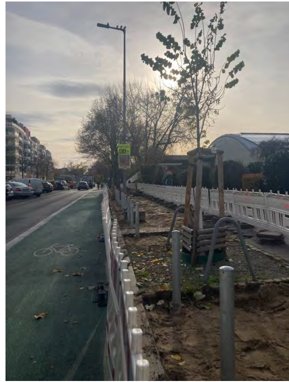
Entsiegelungsarbeiten
